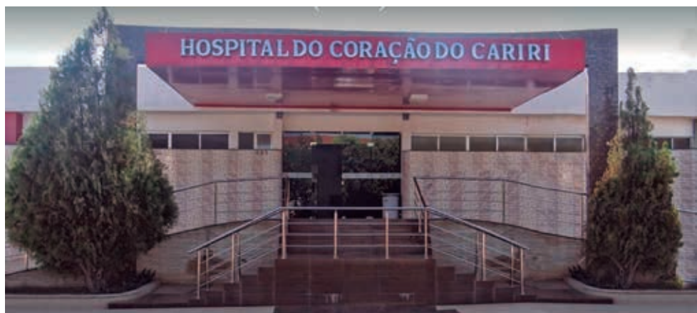
Fachada Hospital do Coração do Cariri
