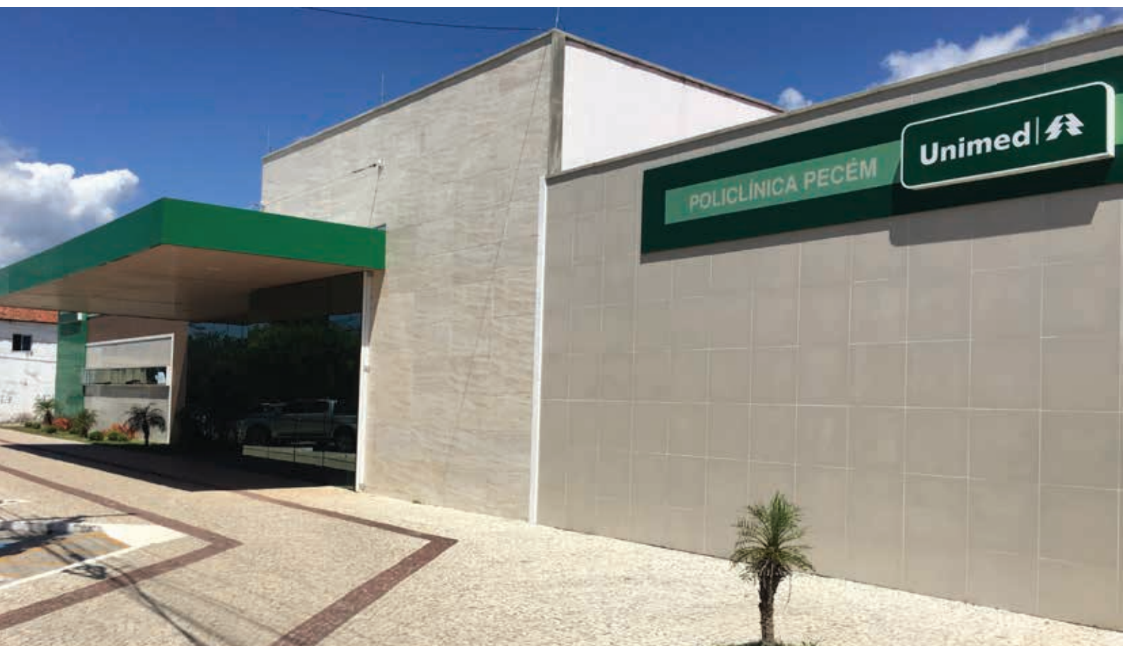
Fachada Policlínica Pecém
