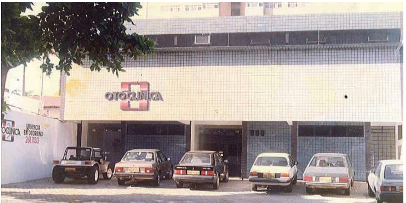
Fachada do Hospital OTOclínica ano 1991
